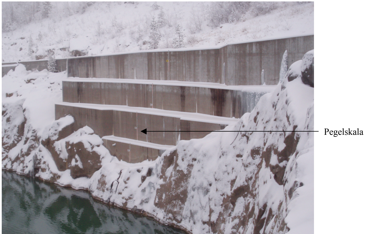
Figur 12 – Bild av pegel (2), pegeln är placerad en bit ut i dammen.
