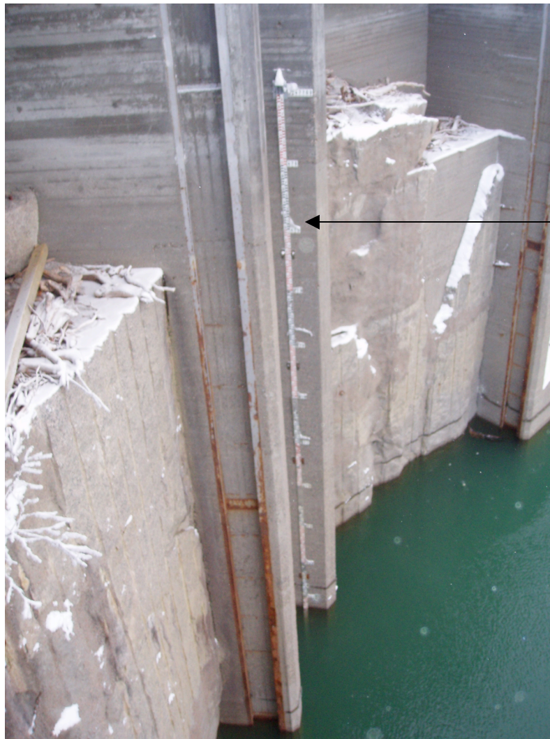
Figur 11 – Bild av pegelskala (1), dompegeln som ideligen går sönder.
