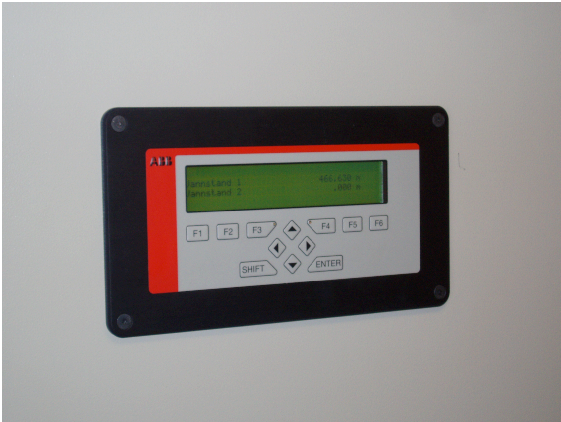
Figur 13 – Displayen i pegelkuren som visar Lehmkuhlpegelns senaste registrerade värde.
