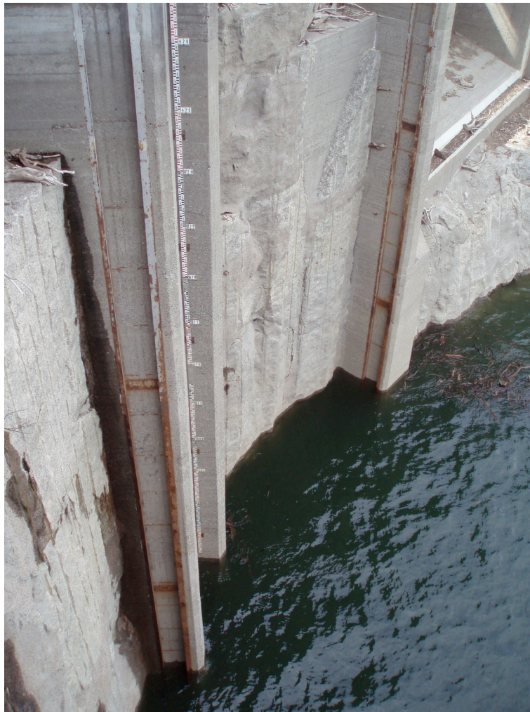
Figur 8 – Den bild som används för att analysera vattenståndet i dammen. Bilden visar att vattenytan ej ligger horisontellt i bilden.
